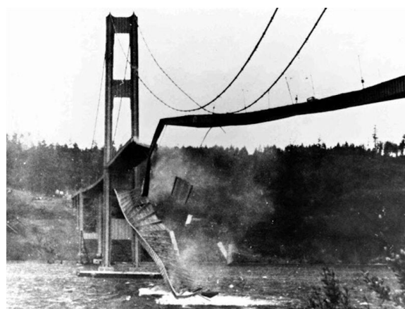
Ponte Tacoma Narrows, colapsou em 1940 devido a um efeito de ressonância com o vento que passava sob a ponte.
